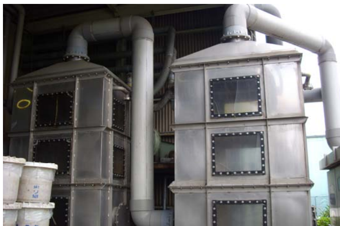
自社工場にある洗浄脱臭機 この機械によって、処理機から発生する悪臭を水洗浄によって除去します。
