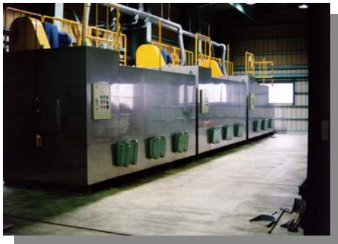
自社生ごみ堆肥化工場
